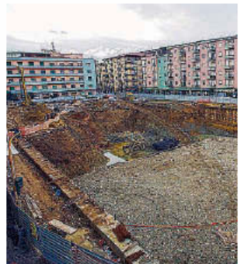
Piazza Bilotti. Commercianti poco soddisfatti dell'andamento dei lavori
