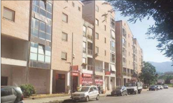
Lo stabile di via degli Stadi. A destra l'ascensore rotto da quasi tre anni
